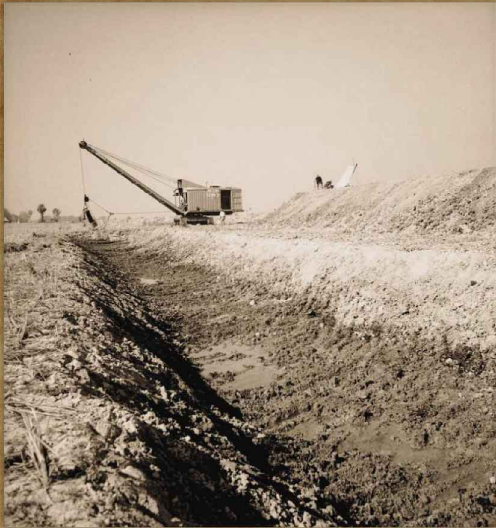
เครื่องจักรกลใช้สำหรับขุดดินเพื่อทำคันดิน บริเวณเขานางบัว อ.เมือง จ.นครนายก, 5 มกราคม ปี 2480
