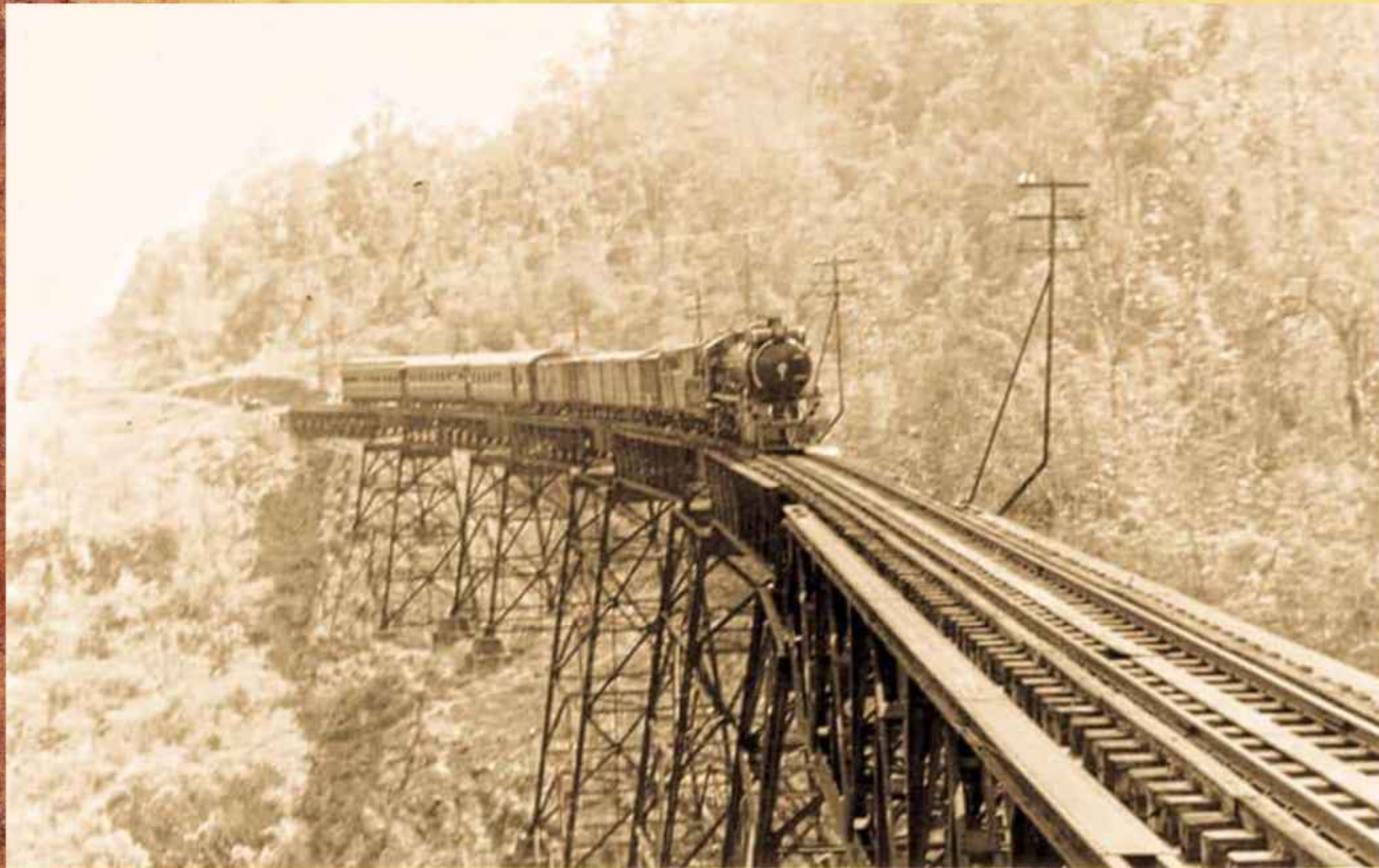
สะพานปางหละ เป็น 1 ใน 3 สะพานเหล็กทอสูง (Viaduct Bridge) ข้ามหุบเขาบนดอยขุนตาล Pang La bridge
