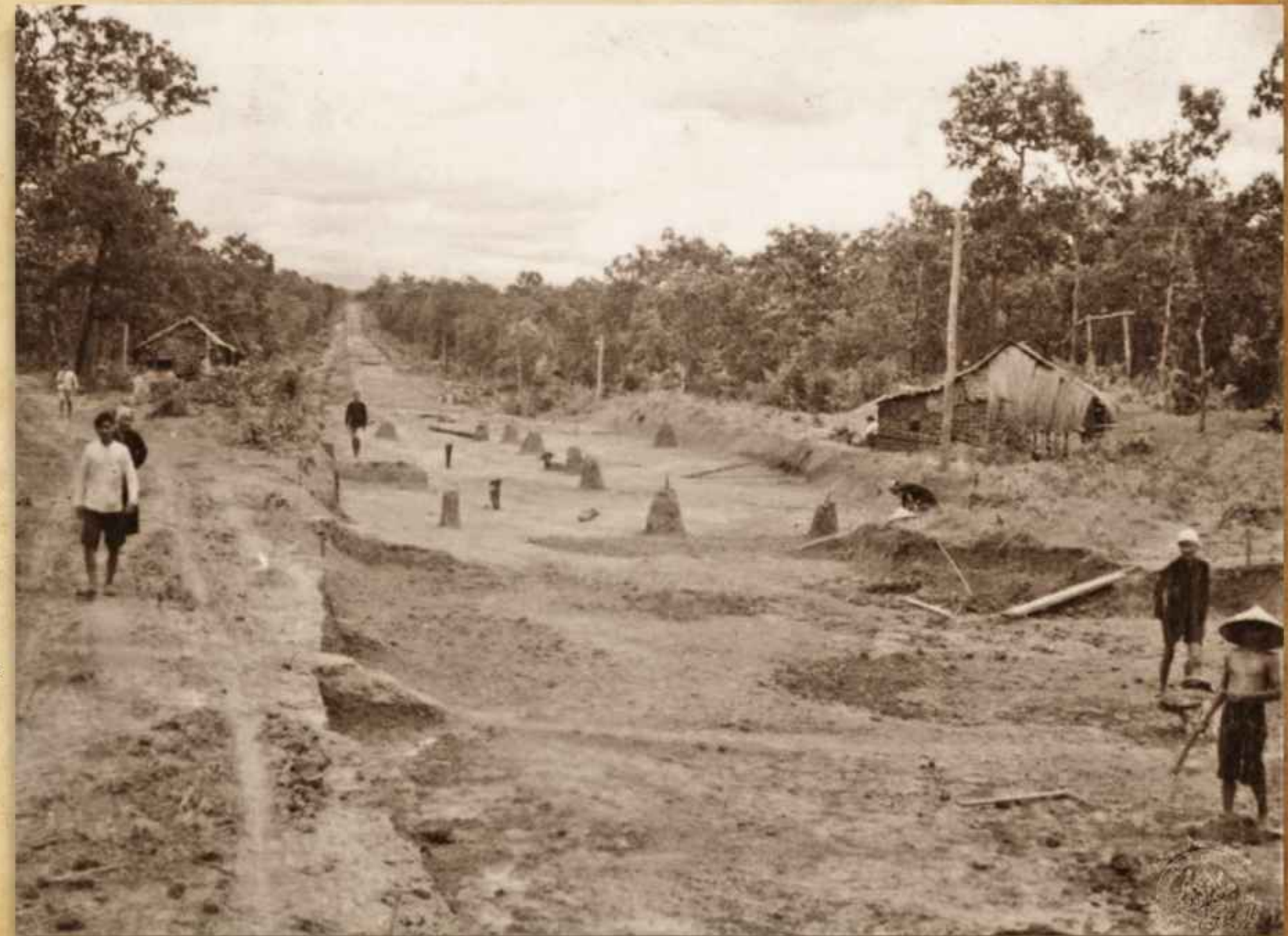
คนงานแบกดินขึ้นไปถมเป็นพื้นรองแนวถนน ในการสร้างทางหลวงแผ่นดินสายอุดรธานี-สกลนคร 29 มกราคม ปี พ.ศ.2481
