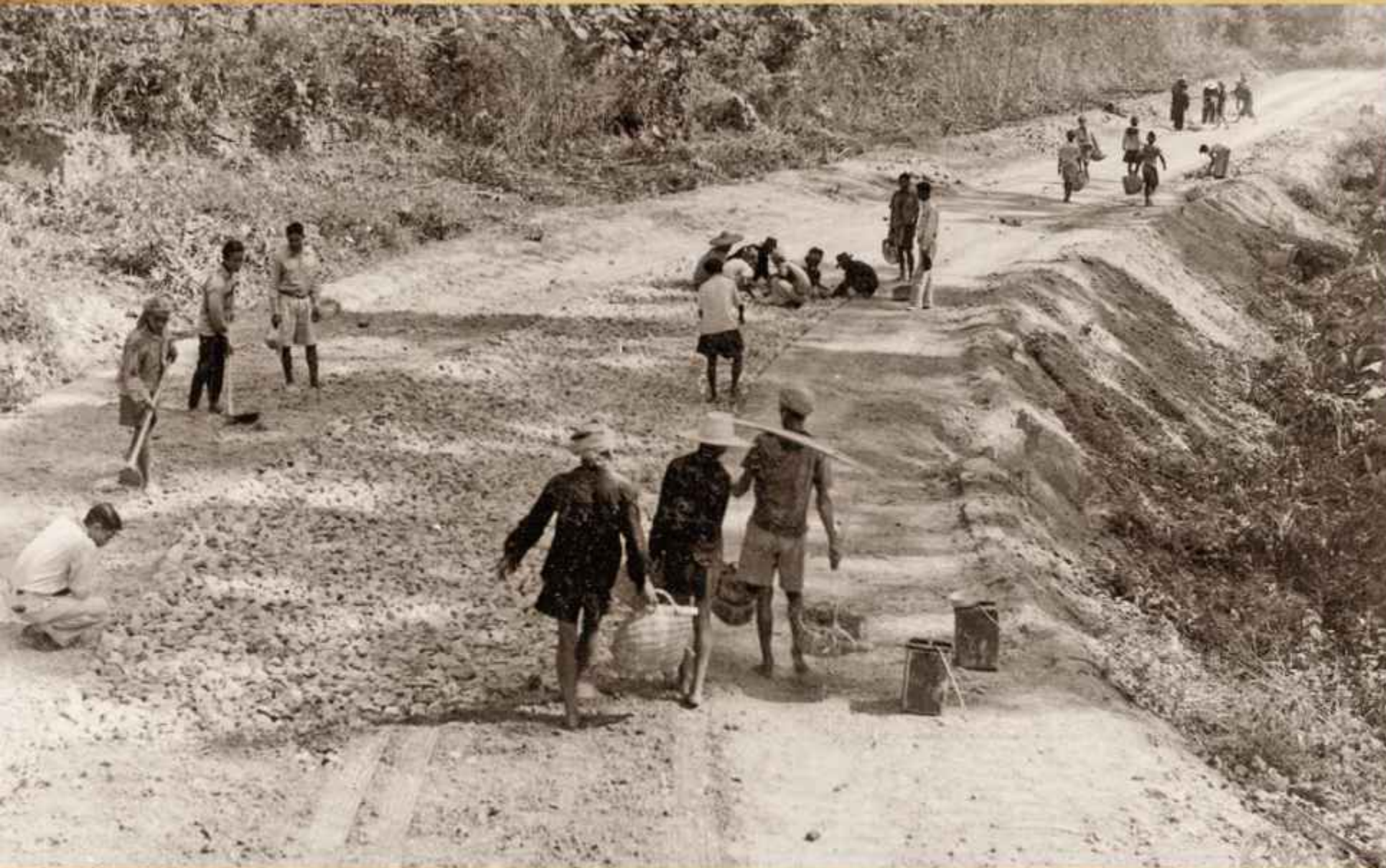
การโรยหินคลุกก่อนบดอัดให้แน่น ทางหลวงแผ่นดินสายระนอง-ชุมพร บริเวณกิโลเมตรที่ 27.6 วันที่ 7 กุมภาพันธ์ พ.ศ.2495 Paving road surface with mixed gravel before steamrolling ,Ranong-Chumphon National Highway at Km.727.6 , February 7,1952 Credit : สำนักหอจดหมายเหตุแห่งชาติ
