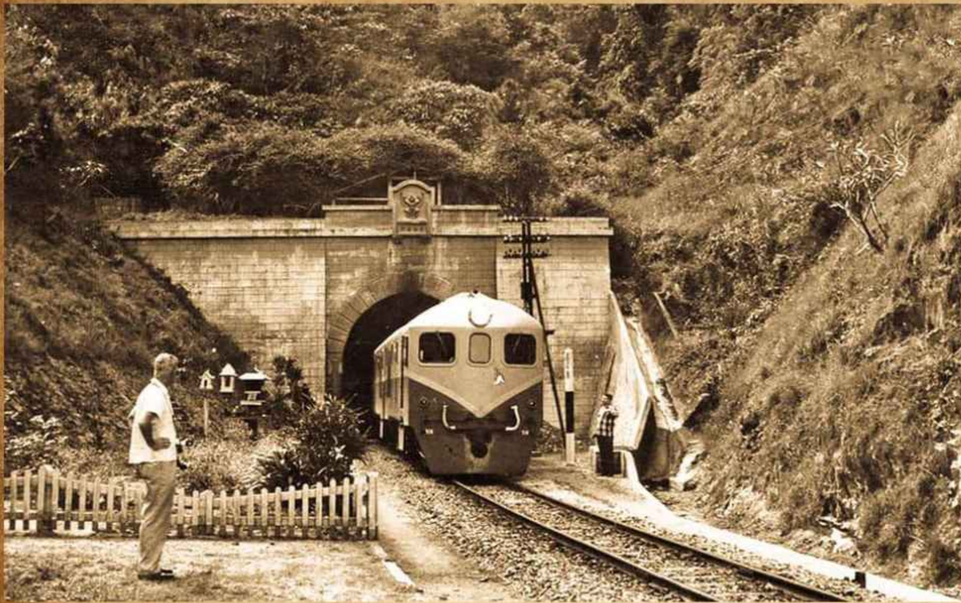
อุโมงค์ขุนตานเสร็จสมบูรณ์ ปี 2461 มองเห็นครุฑอยู่ด้านบน The Garuda Royal Emblem at the north entrance to Khun Tan Tunnel.
