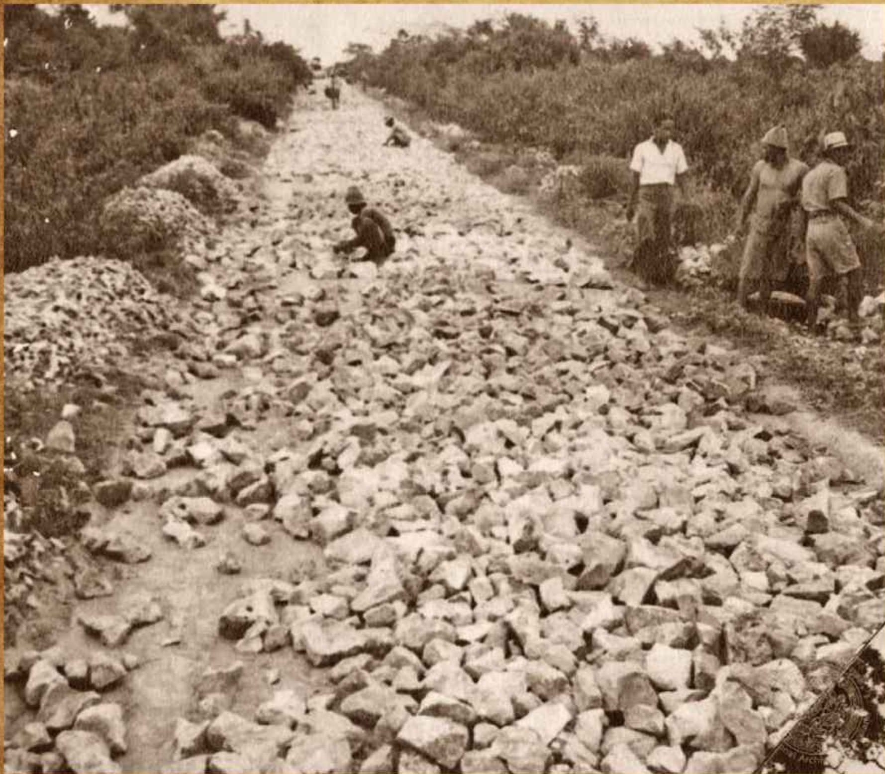
การเรียงหินปู เป็นพื้นถนนแล้วใช้หินคลุกถมทับ แล้วใช้รถบดขนาดใหญ่อัดแรงให้แน่น เรียบเสมอกัน ในการสร้างทางหลวงแผ่นดินสายสุขุมวิท อำเภอสัตตหีบ จังหวัดชลบุรี พ.ศ.2480 Construction of Sukhumwit Road ,the National Highway at Sattahip in 1937, large rocks paved the foundation, topped by mixed gravel then steamrolled and ompacted into road surface Credit : เจ้ากาวิละวงศ์ ณ เชียงใหม่
