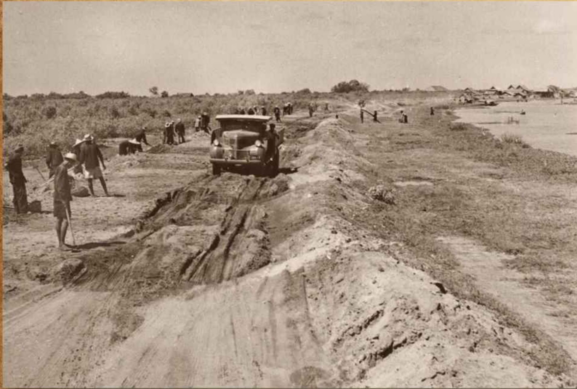
งานปรับพื้นถมดินทำพื้นถนน ในการสร้างทางหลวงแผ่นดินสายสุขุมวิท ช่วงอำเภอบางปะกง จ.ฉะเชิงเทรา พ.ศ.2490 Earthwork for the Construction of Sukhumwit Road, the National Highway at amphoe Bang Pakong, Chachoengsao in 1947, The road is now a part of National Highway No.3 Credit : เจ้ากาวิละวงศ์ ณ เชียงใหม่
