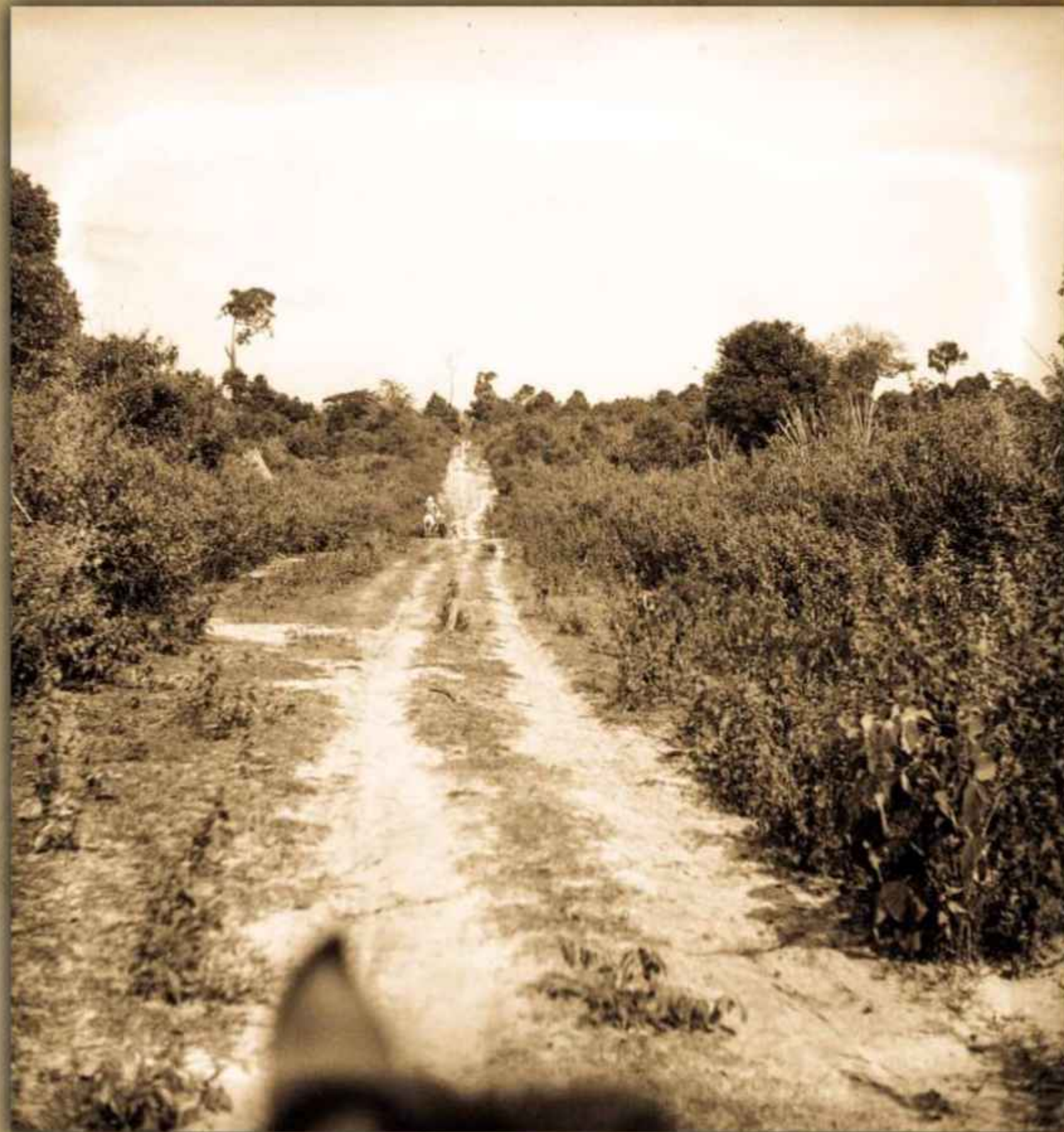
ถนนเส้นทาง บ้านหนองคล้า อ.ท่าใหม่ จ.จันทบุรี (มุมมองจากหลังม้า) 24 พฤศจิกายน ปี 2479
