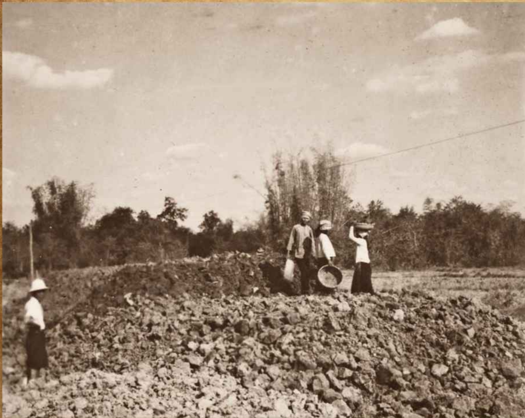
คนงานแบกดินขึ้นไปถมเป็นพื้นรองแนวถนน ในการสร้างทางหลวงแผ่นดินสายอุดรธานี-สกลนคร 29 มกราคม ปี พ.ศ.2481
