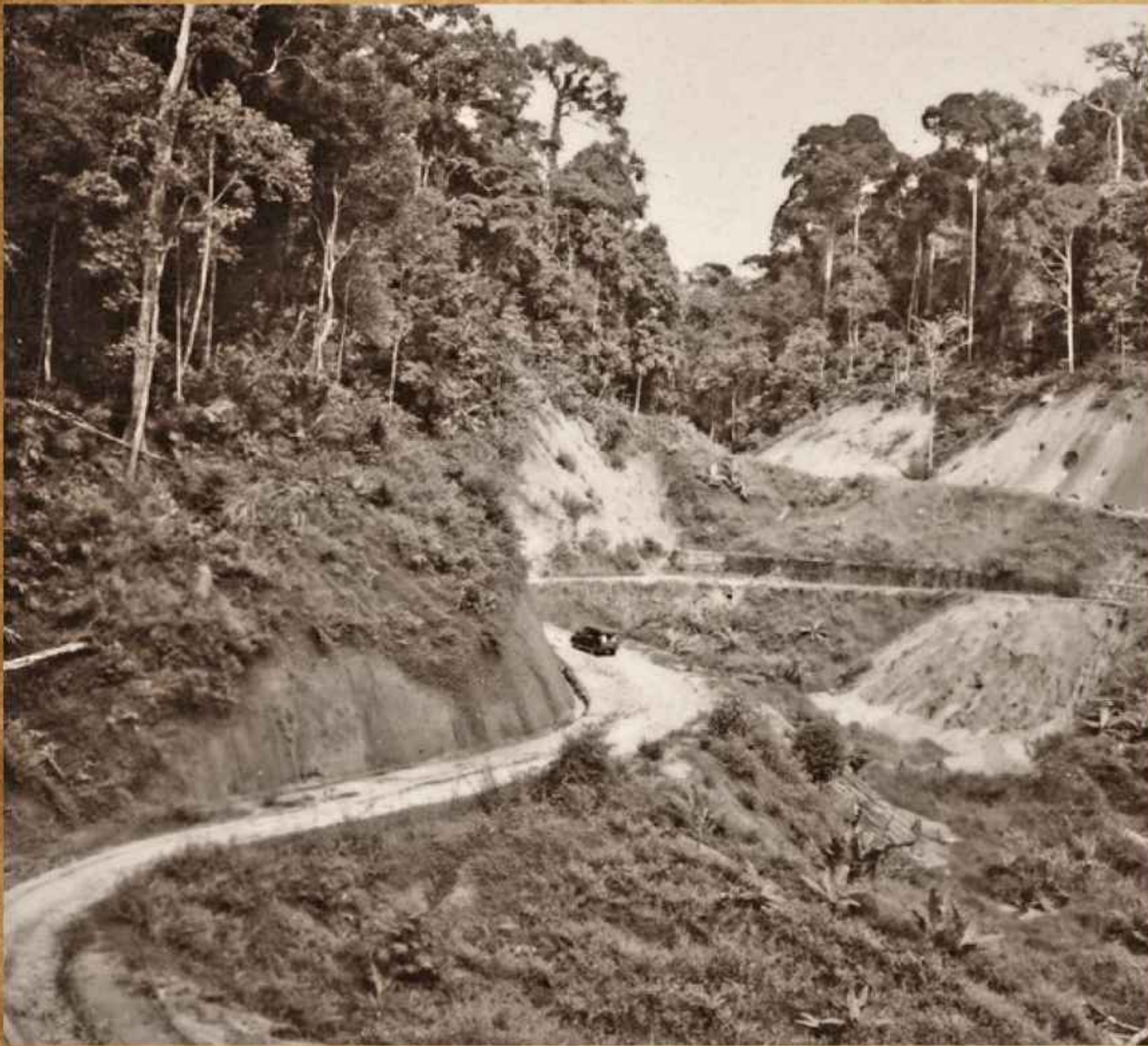
ทางโค้งเขาพิภพผา ทางหลวงแผ่นดินสาย พิทลุง-ตรัง-กันตัง ธันวาคม ปี พ.ศ.2481
