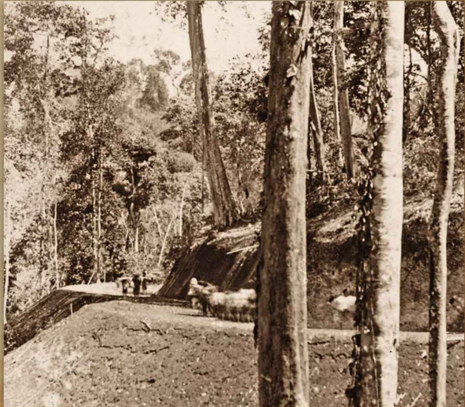
ข้อความกำกับภาพ "ตอนกลางเขาเริบ จังหวัดเพชรบูรณ์" การสร้างทางหลวงสายตะพานหิน เพชรบูรณ์ ตั้งอยู่ระหว่างตัวอำเภอชนแดน - สามแยกวังชมพู จังหวัดเพชรบูรณ์ ปี 2459 The construction of TaphanHin -Phetchabun Highway in 1916 The original caption was the area of Khao Ria Phetchabun Credit : สำนักหอจดหมายเหตุแห่งชาติ
