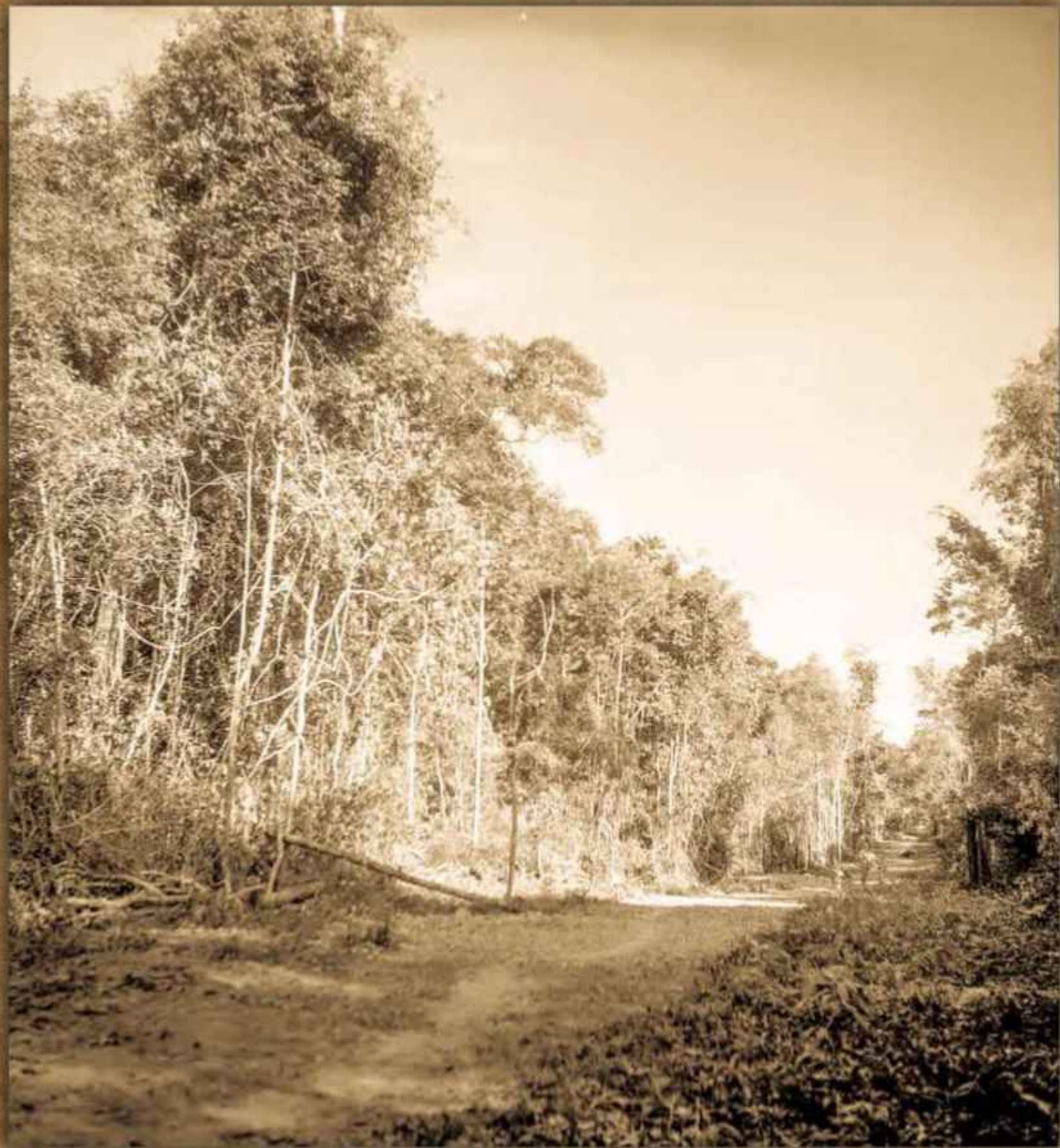
ถนนตัดใหม่ บริเวณท่าแฉลบ ต.บางกะจะ อ.เมือง จ.จันทบุรี 24 พฤศจิกายน ปี 2479
