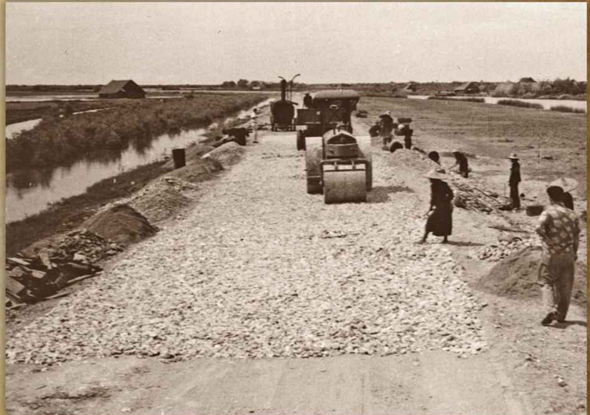
การเรียงหินปู เป็นพื้นถนนแล้วใช้หินคลุกถมทับ แล้วใช้รถบดขนาดใหญ่อัดแรงให้แน่น เรียบเสมอกัน ในการสร้างทางหลวงแผ่นดินสายสุขุมวิท อำเภอสัตตหีบ จังหวัดชลบุรี พ.ศ.2480 Construction of Sukhumwit Road ,the National Highway at Sattahip in 1937, large rocks paved the foundation, topped by mixed gravel then steamrolled and ompacted into road surface Credit : เจ้ากาวิละวงศ์ ณ เชียงใหม่
